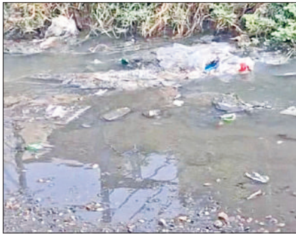
बहादुरगढ़ । सांखोल की नालियों में लीक होते पेयजल पाइप । फोटो : हरिभूमि
